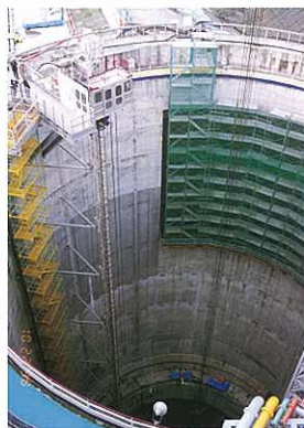
『地下へ伸びる「技術」』 荒木 勝己 (建通新聞社)
